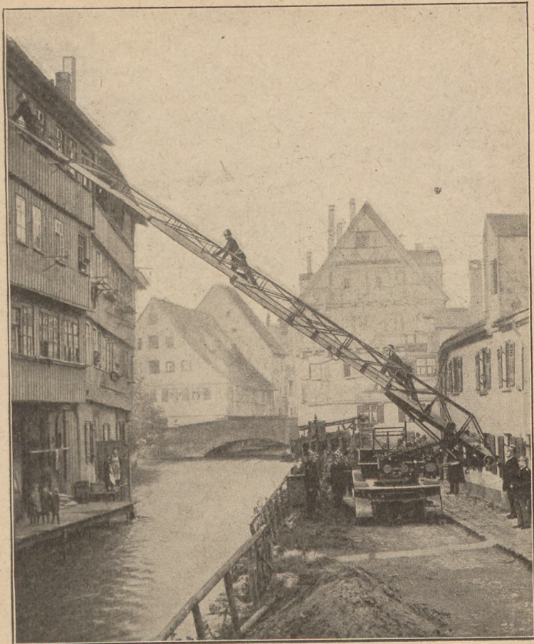
Magirus-Patent-Auto-Drehleiter, ausgezogen und über einen Fluß auf ein Haus geneigt.
