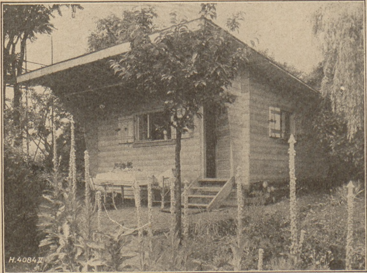
„Der kleine Christoph“, Wochenend-Haus in Blochhausbauweise der Firma Christoph & Unmack A.-G., Niesky O.-L. Entworfen vom Architekten Klaus Hoffmann, Hamburg.
