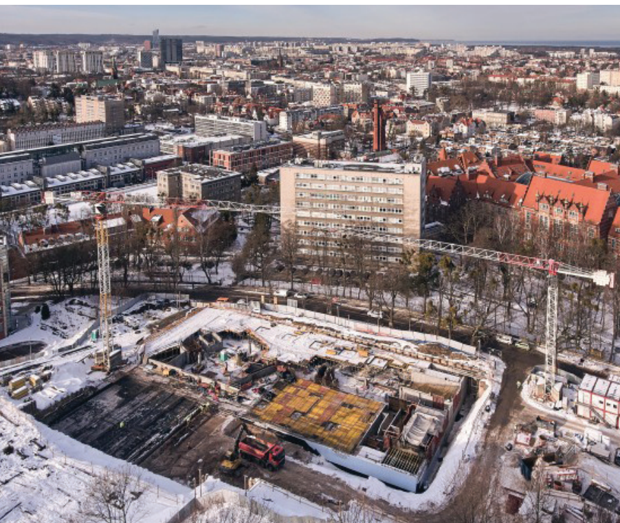
Budowa Centrum Kompetencji STOS Fot. Rafał Malko/NDI
