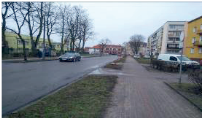
Rys. 4. Fragment ulicy Warszawskiej po rozpoczęciu prac budowlanych
