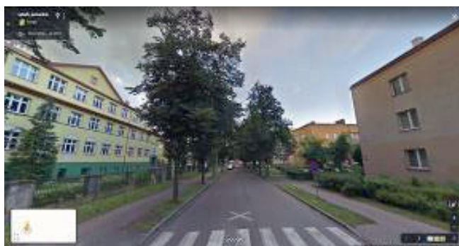
Rys. 3. Fragment ulicy Warszawskiej przed rozpoczęciem prac budowlanych
