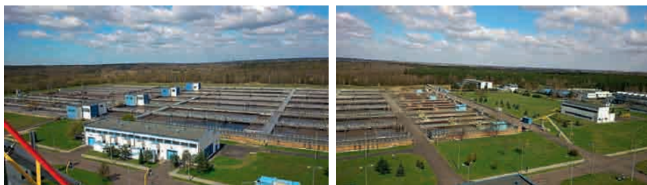
Rys. 1. Grupowa Oczyszczalnia Ścieków w Łodzi
