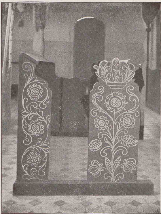
Wejście boczne do ławki kolatorskiej w Obozinie.
