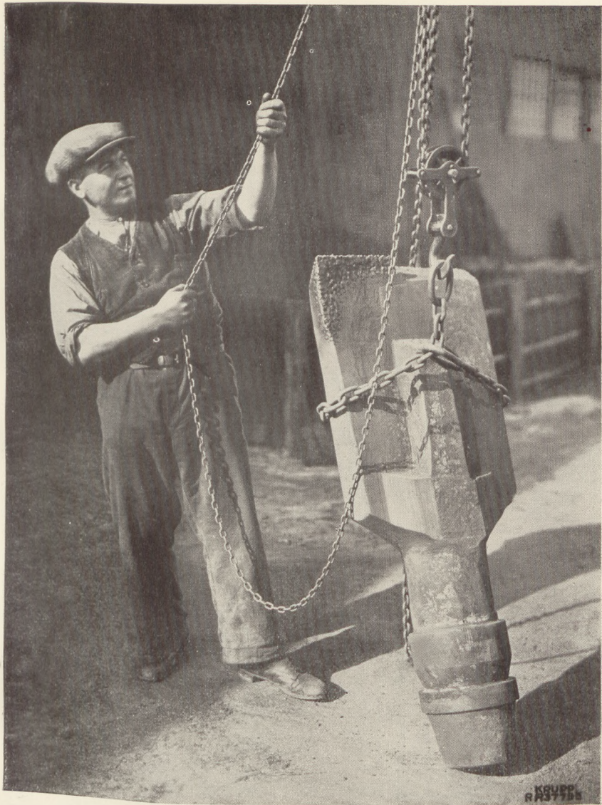
Fischschwanzmeißel für Erdölbohrung, an den Schnittkanten mit hartem Widiametall besetzt.
