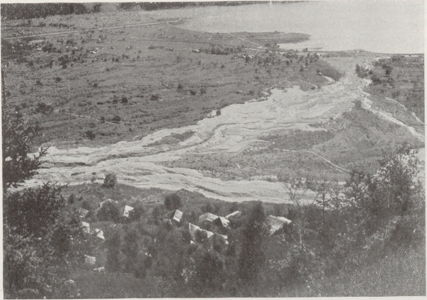
Fig. 259 Schlammstrom von Kienholz am Brienersee 1896, Ablagerungsgebiet (phot. A. Baltzer)
