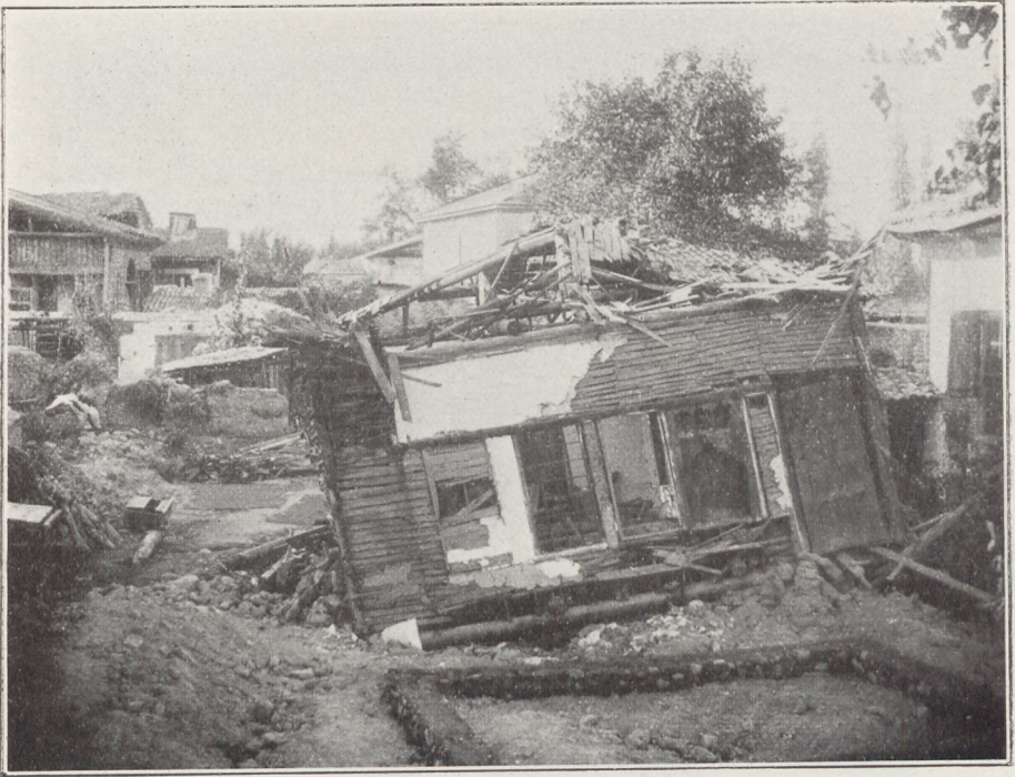
Fig. 203 Von seinem Unterbaue weggeshobenes Haus in Denizli, Mäandertalbeben, Kleinasien 1899 (nach einer käuflichen Photographie)
