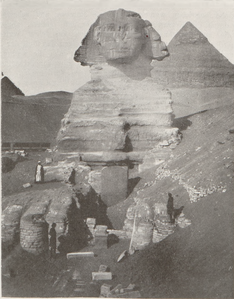
Fig. 361 Winderosion und Verschüttung durch Sandwehen am Sphinx, Ägypten (nach einer Aufnahme von L. Fiorillo, Kairo)
