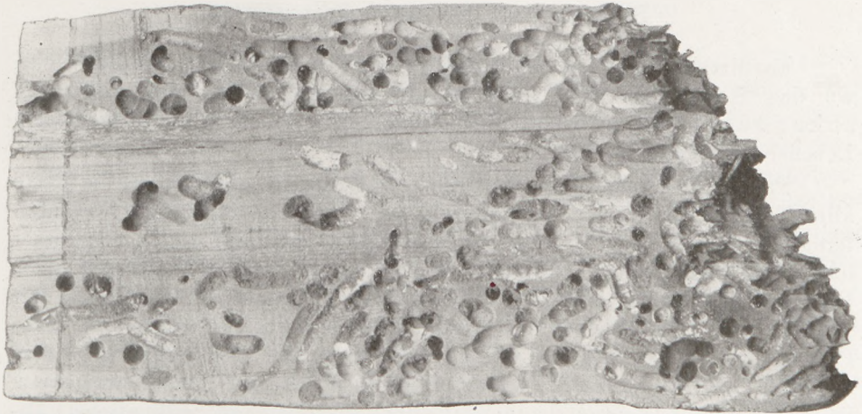
Fig. 461 Von Bohrwürmern zerfressenes Holz
