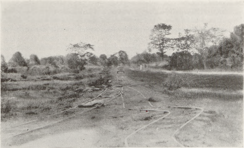
Fig. 199 Gebogene Schienen bei Rangapara, Indien, Erdbeben am 12. Juni 1897 (nach R. D. Oldham)
