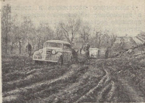
Рис. 3. Глубокая грязь на объезде ремонтируемого участка шоссе.
