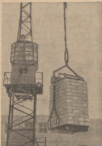
Рис. 5. Подъем башенным краном малого поддона с кирпичом.
