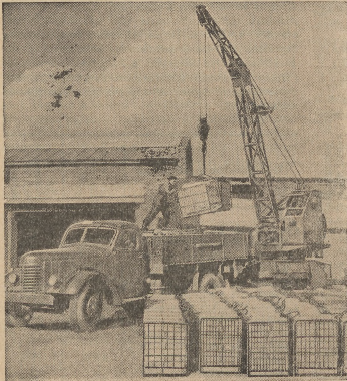
Погрузка кирпича в контейнерах. Фото М. Прехнера.
