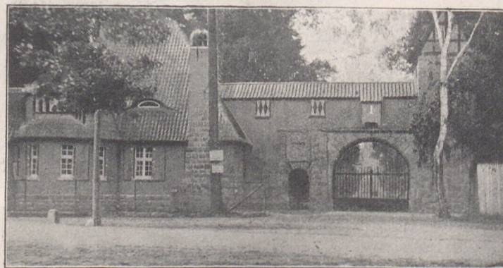
Bilder aus Kl.-Madnaw: Portal der neuen Hakeburg.
