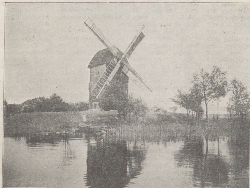
Cablower Mühle an der Dahme.
