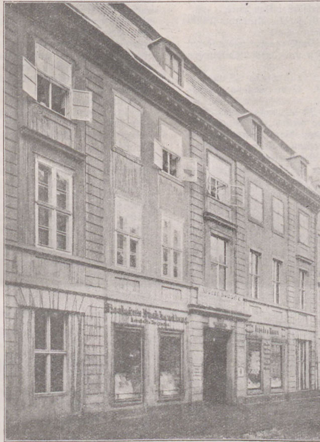
Das neue Bessinghaus in der Brüderstraße.
