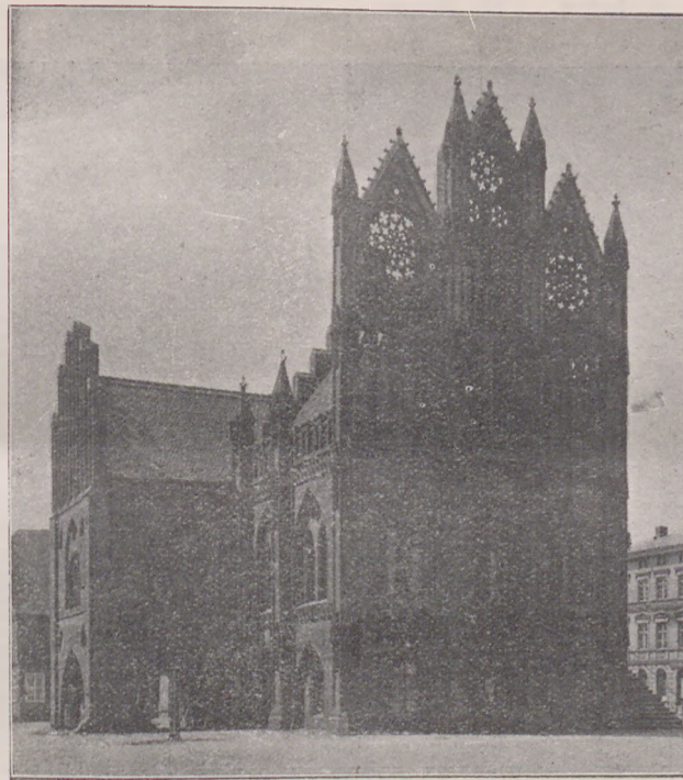
Mittelalterliche Bauten der Altmark: Rathaus in Tangermünde.
