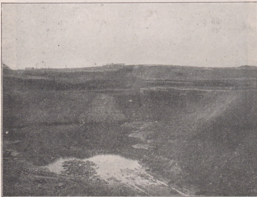
Kleinerer Abbau in den Tonlagerungen („Pötter“-Bergen) bei Velten.
