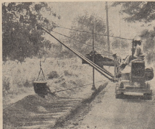
Rys. 9. Koparka z kubłem wleczonym i ubijakiem.
