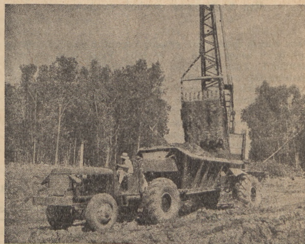
Rys. 7. Koparka z wleczonym czerpakiem ładuje ukop na wozidło.
