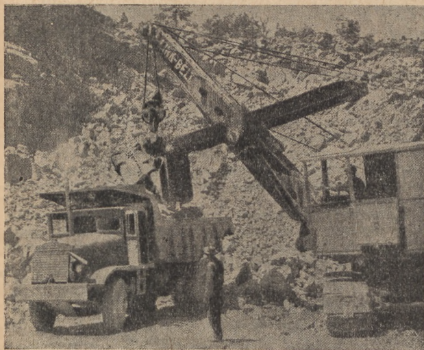
Rys. 2. Koparka z wysokościową łopatą.
