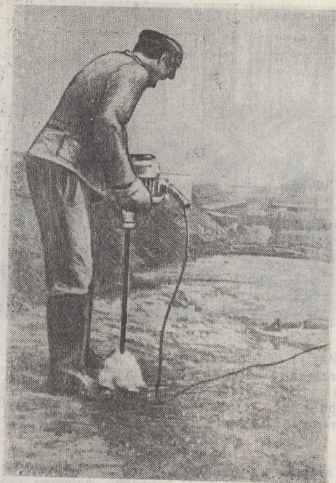
Рис. 2. Бурение шпуров электросверлом.
