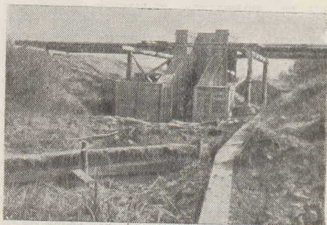
Рис. 2. Строительство нового рыбного пруда (закладка бетонного водоспуска).
