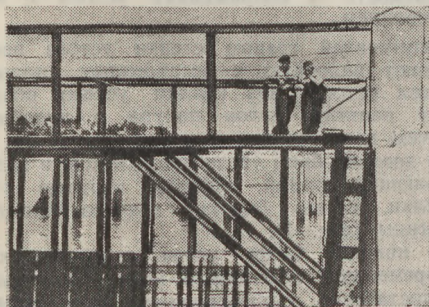
Рис. 3. Мостозая конструкция незаконченного водосброса, без настила моста:
