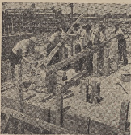
Cementownia Wierzbica — fragment budowy (fot. CAF)
