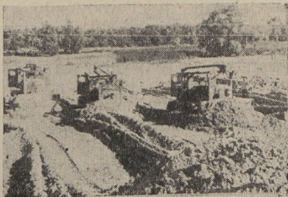
Roboty ziemne na budowie
