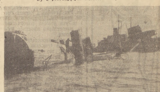
Wrak został wydobyty, ale na tym nie kończą się prace PRO. Trzeba go teraz uszczelniać, zabezpieczyć i przyholować do portu.
