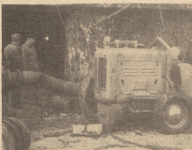
Czy przypominacie sobie nietatwą pracę nad uszczelnieniem stalowego kołosa „Jastarni”? Każdą sprawę omawiał kpt. Poinc z kolektywem „Smoka” i „Światowida”, nawet ustawienie pomp (na zdjęciu). I tak właśnie współpracę trzeba wprowadzić w codzienną praktykę.
