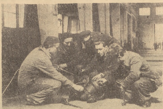
Brygada monterów maszynowych Kaniewskiego należą do produkujących zespołów roboczych w Szczecińskiej Stoczni Remontowej. Przekraczając wysoko normę, monterzy wykazują wiele troski o wysoką jakość wykonywanych prac.
