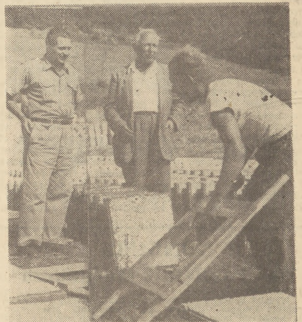
Kpt. Andrzej Goebel i kierownik (Warszawskiej Spółdzielni Budowlanej) inż. Stefan Zagrodziński na placu budowy w Orłowie badają prefabrykowane płyty, z których będą budowane domki.
