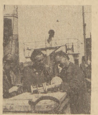
W pracach remontowych na s/s „Lublin” wyróżnia się brygada rurarzy mistrza Jaszy .
