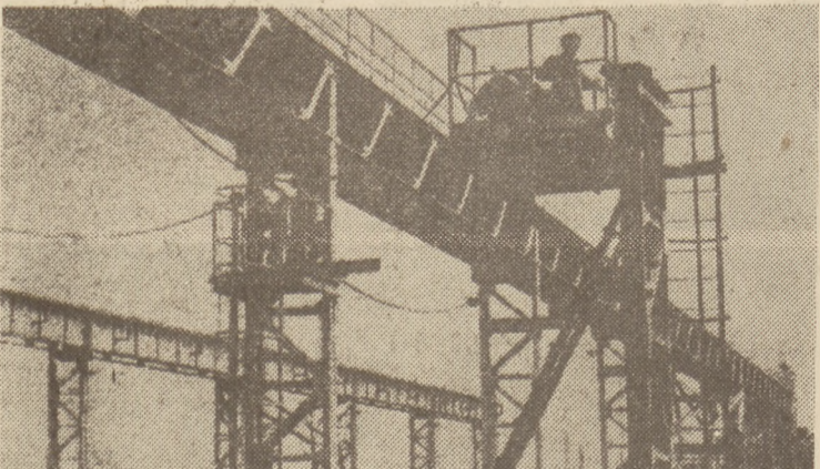
Rosną budule socjalizmu w Polsce. Niedawno ukończono w Nowej Hucie montaż ogromnego transportera nitrotytalowego produkcji radzieckiej.
