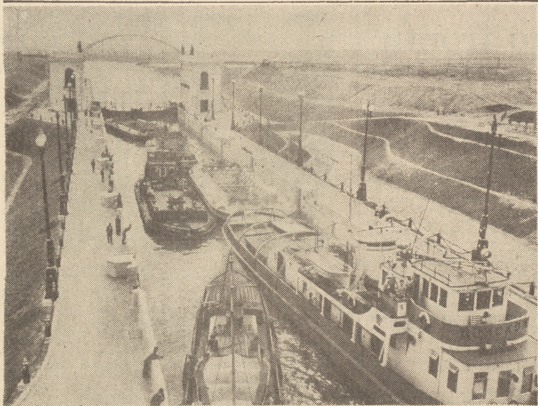
Pociąg barek w ósmej służbie kanału Włga — Don. Służowanie na nowej magistrali wodnej jest całkowicie zelektryfikowane i zautomatyzowane. Dlatego odbywa się ono szybko i sprawnie
