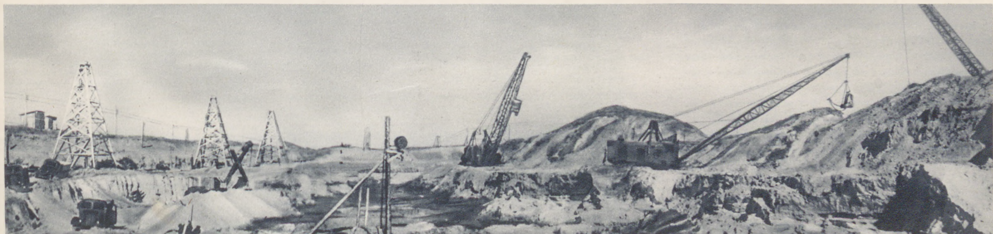
Огромный масштаб земляных работ на строительстве нового судоходного пути из Волги в Дон. Выполнить эти работы в короткий срок позволяет высокая оснащенность строительства мощными экскаваторами, различными механизмами и транспортными средствами. На снимке — панорама котлована на одном из участков будущего канала. Слева — буровые вышки скважин глубинного водоотлива, справа — шагающие экскаваторы в работе.
