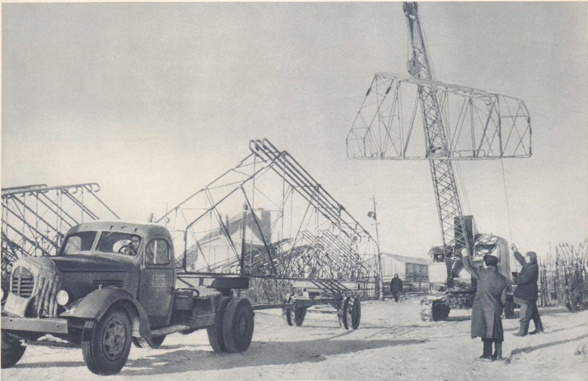
На арматурном дворе строительного района. Собранные здесь фермы грузятся на автомашины и доставляются к месту сооружения шлюза.
