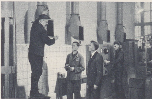
„До исправления вентиляции мы не разрешим здесь работать!“, — говорят председатель комиссии охраны труда заводского комитета профсоюза А. Жуков и общественный профсоюзный инспектор охраны труда слесарь А. Гайдуков. Начальник цеха И. Колесников распорядился немедленно отремонтировать вентиляцию.
