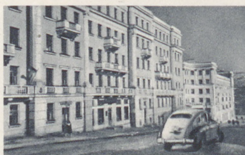
Новые жилые дома для рабочих Владивостокского механического завода.
