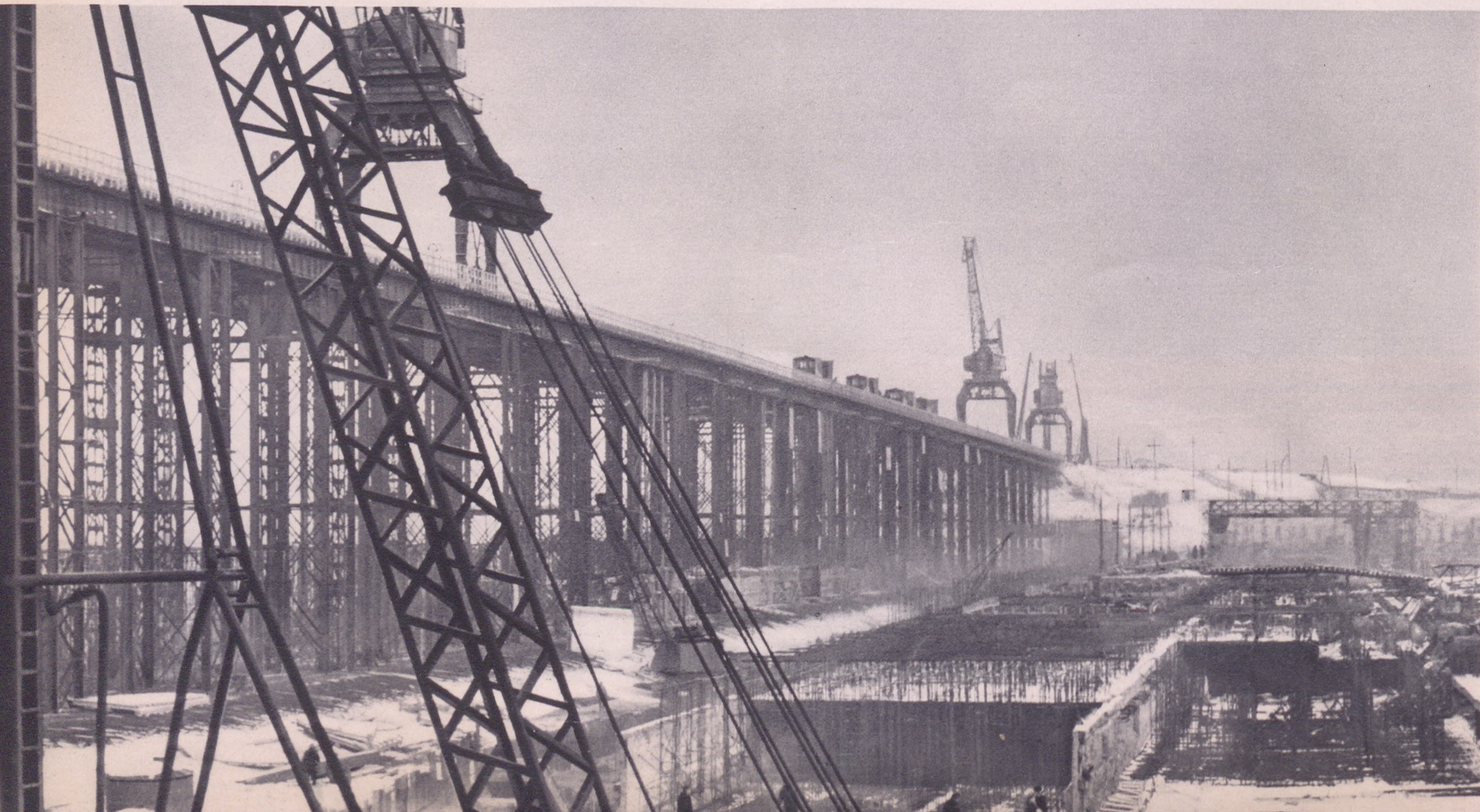
Все гуще становится сеть железнодорожных линий на строительной площадке Куйбышевского гидроузла. На снимке — механический путеуладчик и мостовой кон- сольный кран на строительстве нового под'ездного пути.
