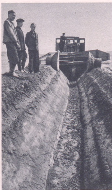
Каналокопатель прокладывает временный оросительный канал на землях колхоза имени Навои в Узбекистане.
