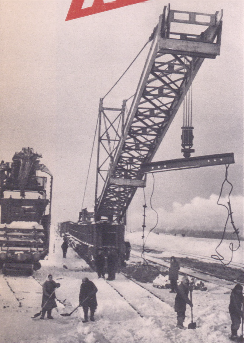
Все гуще становится сеть железнодорожных линий на строительной площадке Куйбышевского гидроузла. На снимке — механический путеуладчик и мостовой кон- сольный кран на строительстве нового под'ездного пути.
