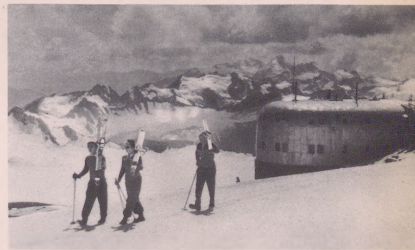
Альпинистский отель „Приют одиннадцати“ на Эльбурсе, сооруженный на высоте 4.200 метров над уровнем моря.
