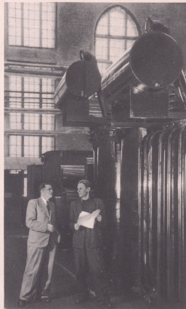
„Трансформаторы готовы!“ — телеграфировали из Москвы на строительство Куйбышевской гидроэлектростанции. Заместитель главного энергетика стройки инженер К. Ступишин приехал в столицу, чтобы принять от трансформаторного завода готовый заказ.
