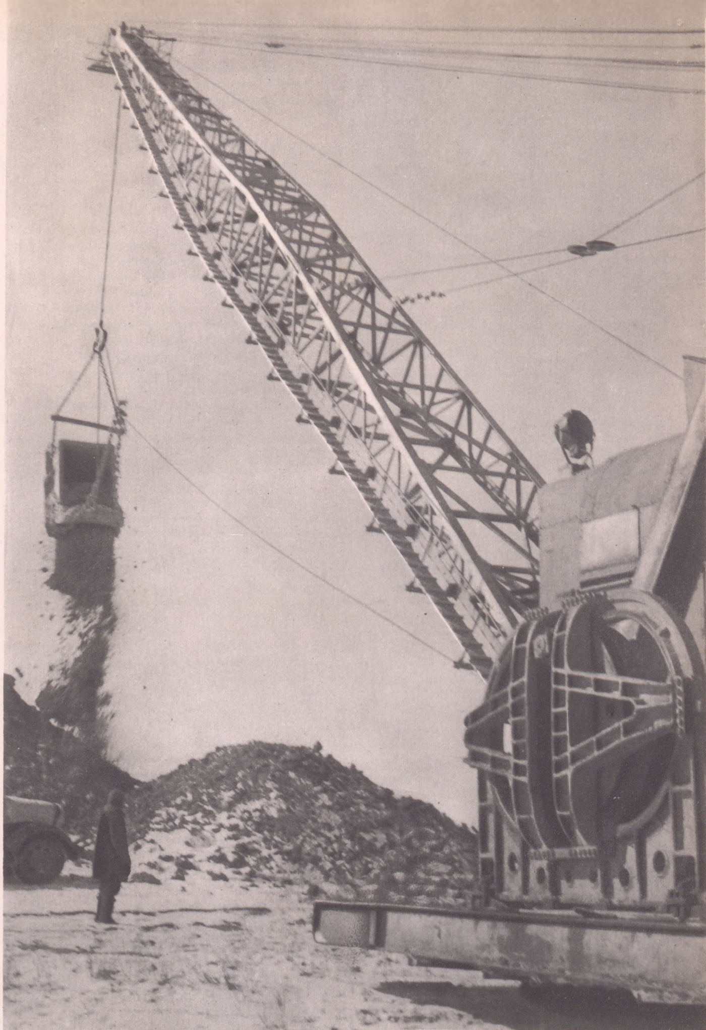
Предприятия страны досрочно выполняют заказы великих строек коммунизма. Все новые и новые машины прибывают на строительство Волго-Донского канала. На снимке — шагающий экскаватор за работой.
