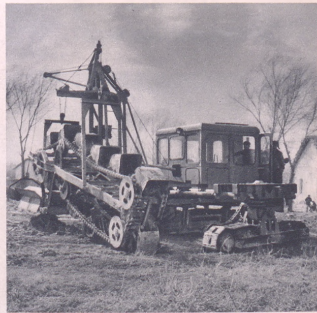
Многоковшовый экскаватор — один из многих механизмов, находящихся в распоряжении машинно-экскаваторных станций.
