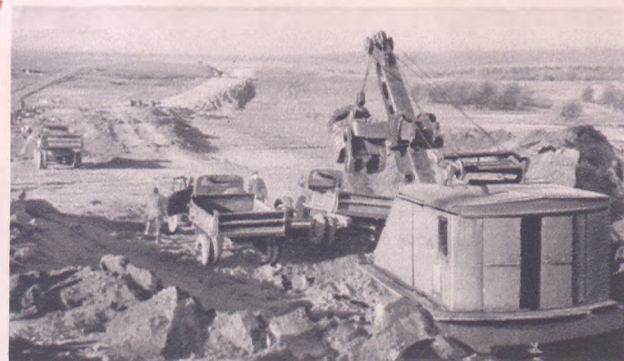
Земляные работы на строительстве Куйбышевской гидроэлектростанции.
