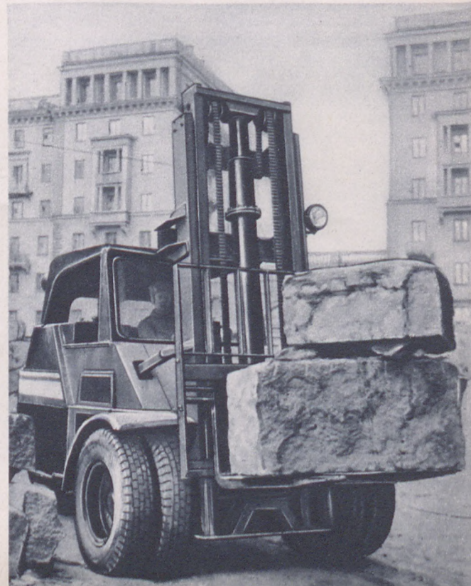
Слева — разгрузка леса из вагона-гондолы с помощью захватного приспособления автопогрузчика. Внизу слева — автопогрузчик с ковшом, успешно применяемый на погрузке угля, шлака, песка и т. п. Внизу справа — автопогрузчик с вилочным захватом перевозит к месту работ блоки гранита.
