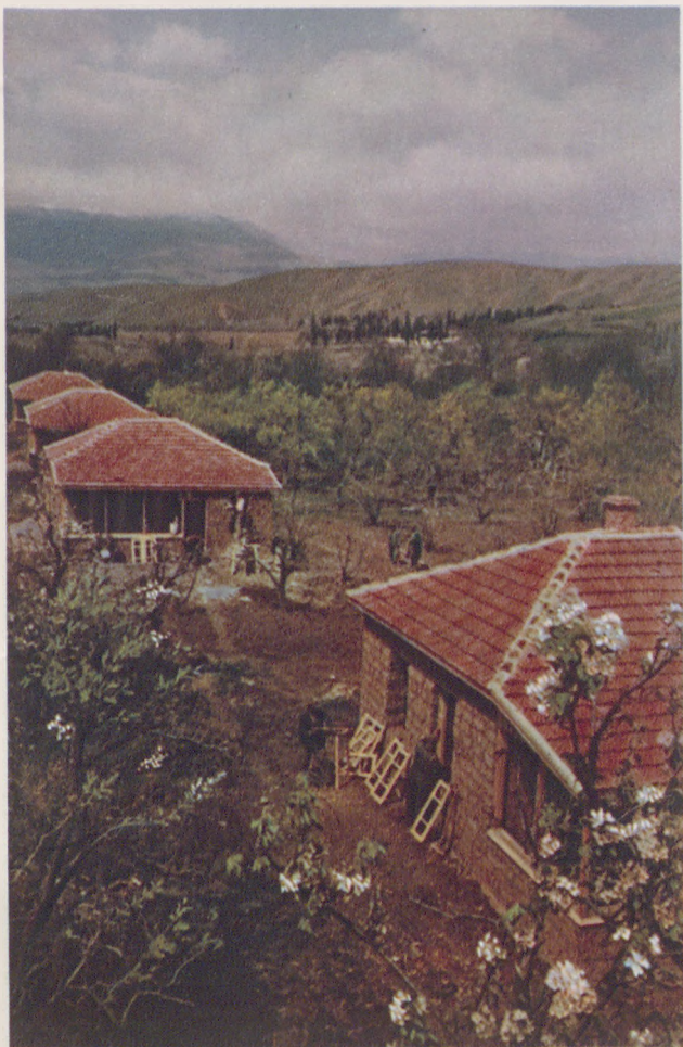
Осваивая новые земли, колхозы Крыма становятся еще зажиточнее, строят новые дома. На снимке — строительство новых домов в колхозе „Память Ильича“, Алуштинского района.
