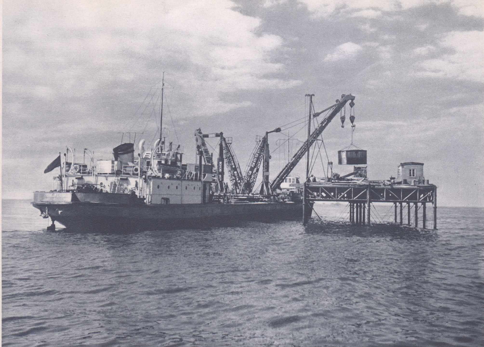
Пловучий кран установил в открытом море секции нового стального островка. Теперь на островке идет монтаж оборудования буровой вышки и подсобных помещений.
