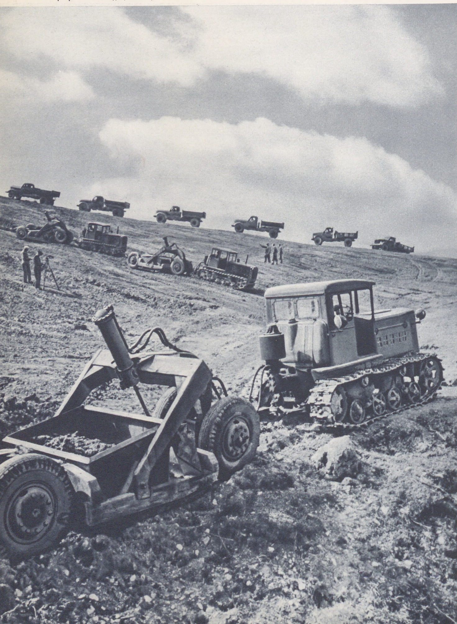
На нижнем снимке — строительство Старокрымского водохранилища.
