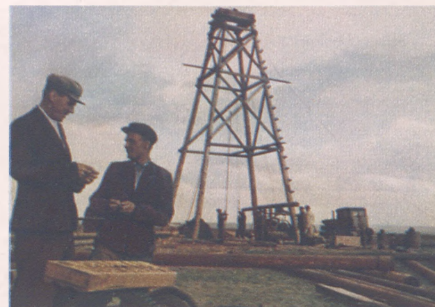
На трассе будущего канала производятся геологические изыскания. На снимке — участники геолого-разведочных работ Г. Козинец и А. Мельниченко рассматривают пробы грунта.
