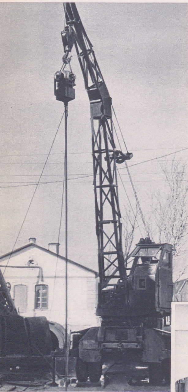
Проходка геолого-разведочной скважины вибрационным методом.
