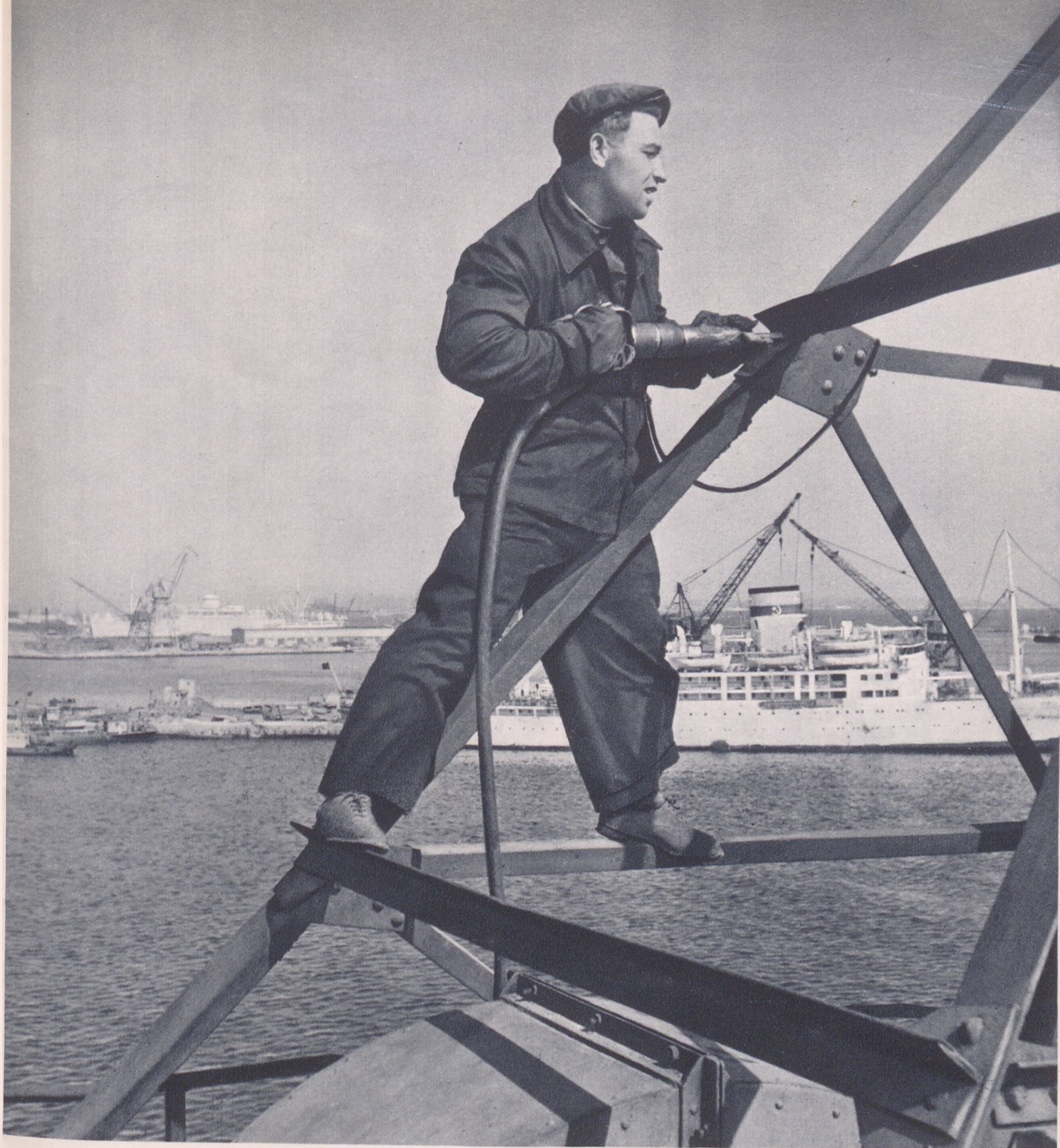
Петр Брюшко работает теперь клепальщиком на ремонте судов.
