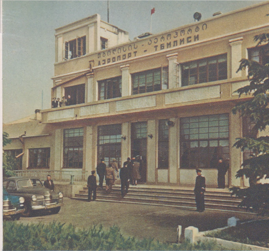
Здание вокзала Тбилисского аэропорта.
