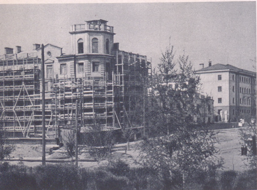
В городе Серове ведется большое жилищное строительство. На снимке — постройка нового жилого дома для металлургов.
