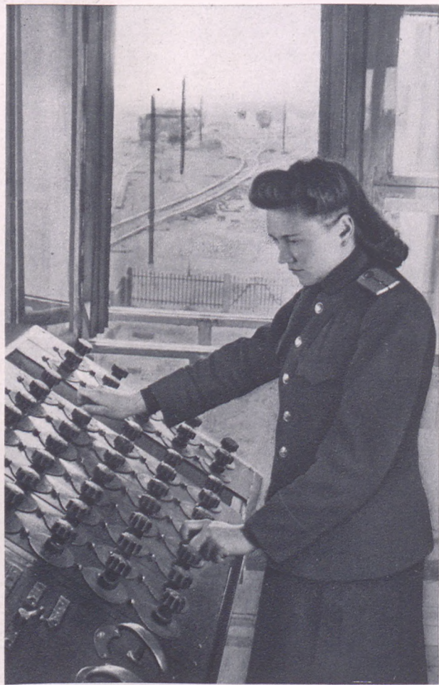
На железных дорогах СССР при формировании составов широко применяется автоматическая централизация. С помощью электромеханических устройств на горках переводятся стрелки, сортируются в необходимой последовательности вагоны. На снимке — оператор механизированной горки В. В. Новикова у пульта управления. Слева — эшелон с автомобилями, сформированный на автоматической горке.
