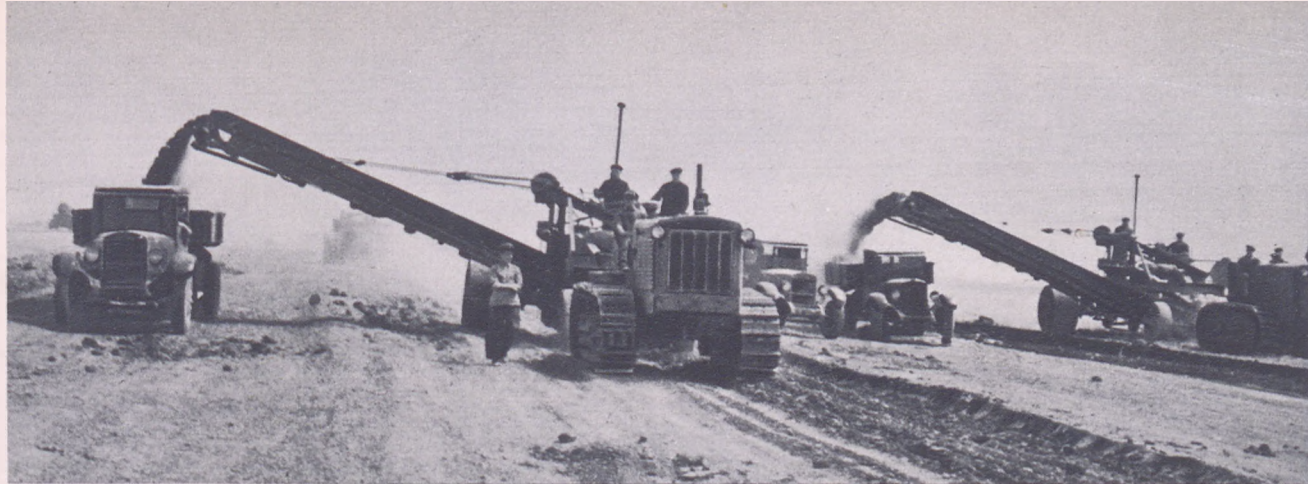
Много различных машин работает на строительстве новых железнодорожных магистралей. На снимке — грейдеры-элеваторы.
