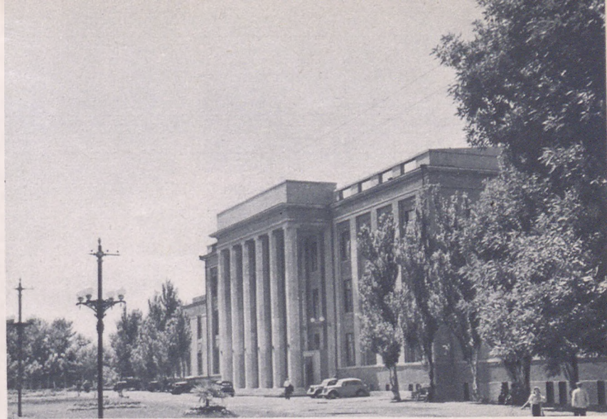
Здание заводоуправления „Ростсельмаш“.
