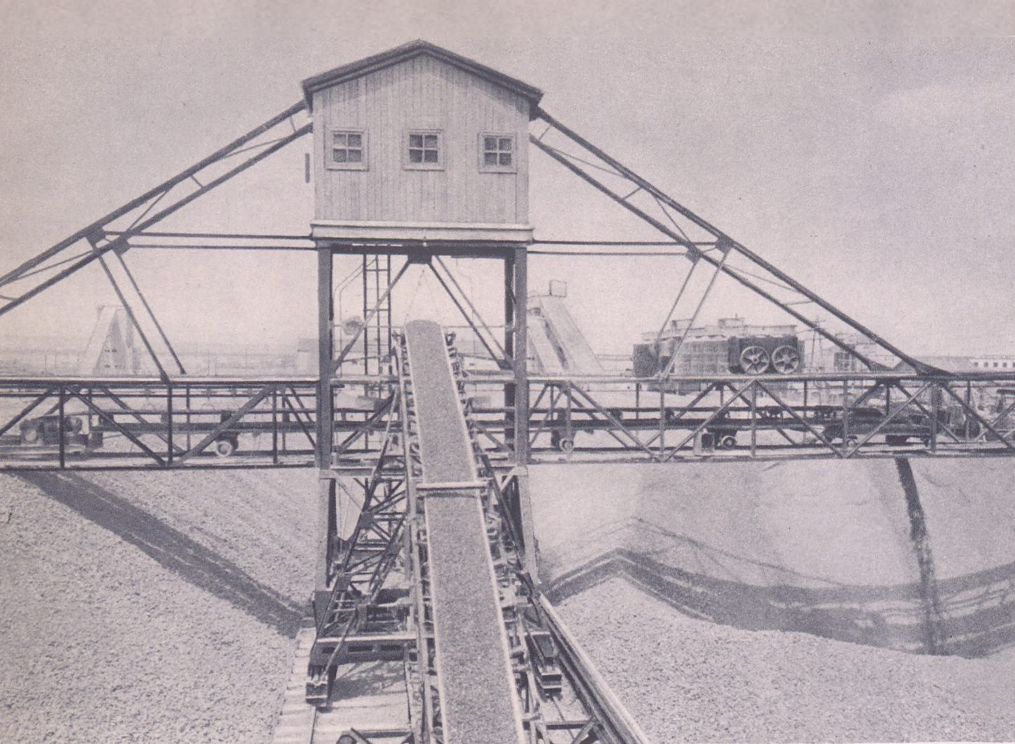
Механизмы выгружают гравий с железнодорожных платформ и укладывают в штабелю на заводском складе.
