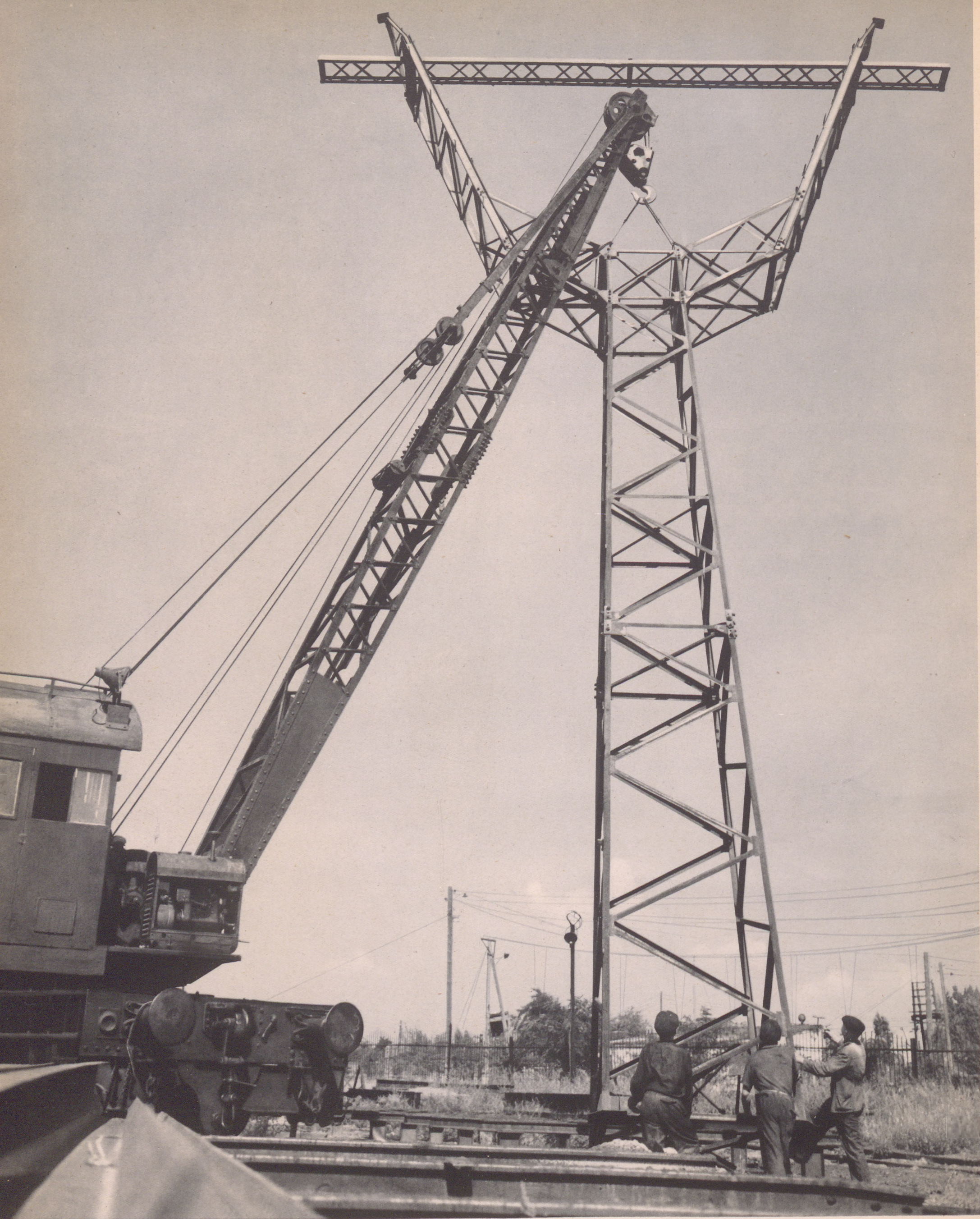
На строительстве Каховской гидроэлектростанции. Установка металлических опор для линии электропередачи. По этой линии энергия пойдет на строительную площадку.
