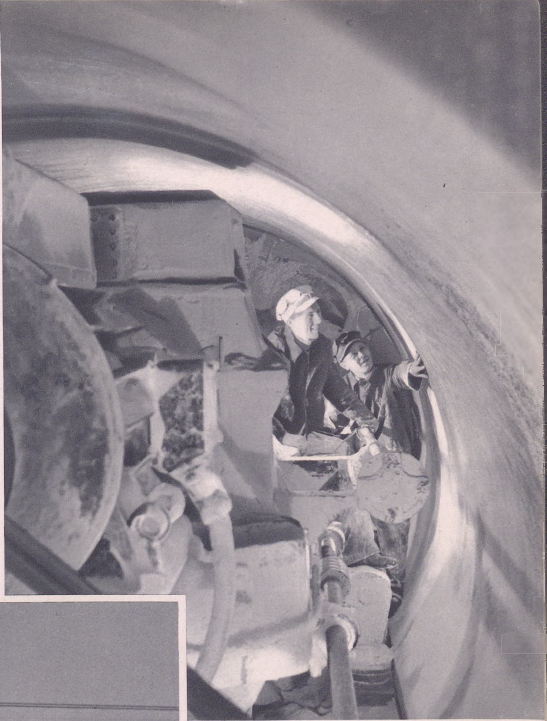
Штрекопроходческий комбайн в забое одной из соликамских шахт. У комбайна — обслуживающие его машинисты П. Костоломов (справа) и Н. Попов.
