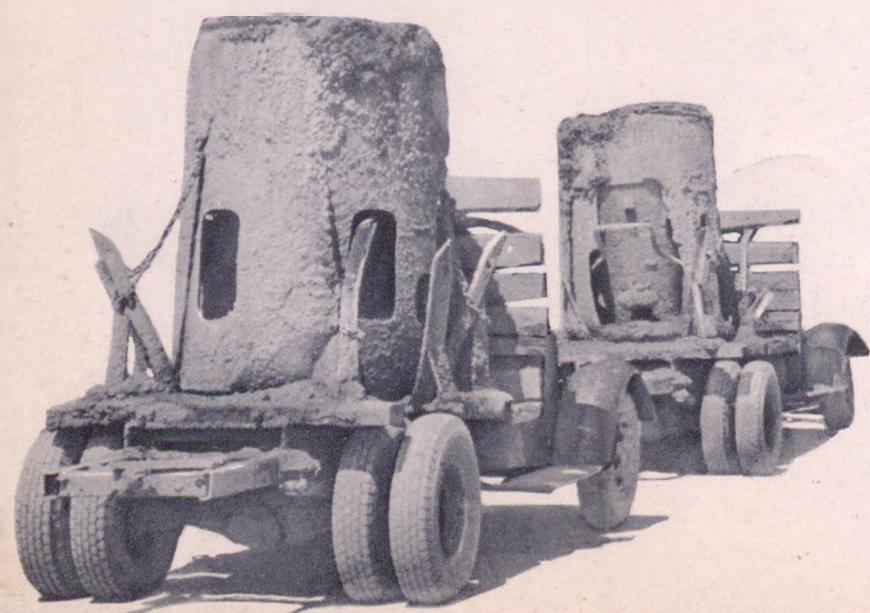
Слева — семитонные автосамосвалы специальной конструкции, доставляющие бетон на строительную площадку.
