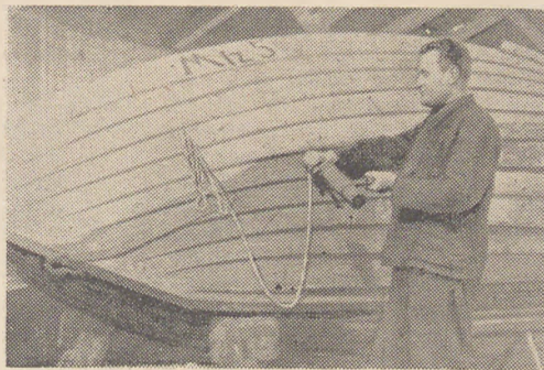
Na zdjęciu: szutnik Edmund DATA przy uszczelnianiu kadłuba łodzi motorowej „Miz 5”.
