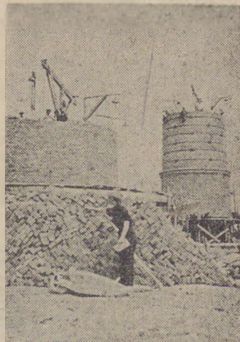
Fragment budowy kominów kokso-nych w Nowej Hucie.
