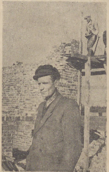
Szypier KOS na dole swojego budowanego domu we Władysławowie. Fot.: M. Syrowatko
