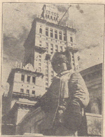
Oto spawaczka Nina JEFIMOWA, wyrabiająca 150 proc. normy przy budowie Pałacu Kultury i Nauki w Warszawie
