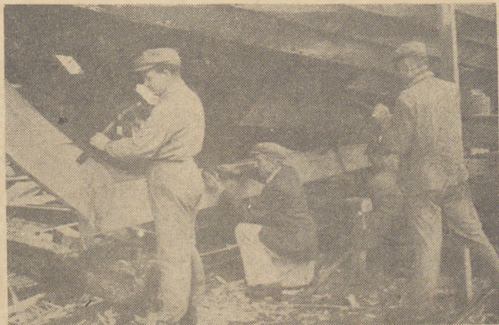
Kuter „Dzi 28“ podczas remontu na stoczni w Nowym Warpnie. Na pierwszym planie (od lewej) tow. Wiśniewski, inicjator skrócenia remontu o 10 dni, dalej — szkutnicy Brygiert, Mansa i Strzelczyk.
