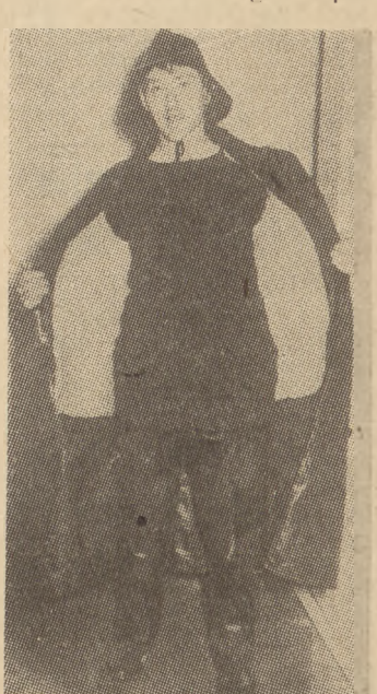
Wstawki (te białe) zapewniające pływerność wszyte są po wewnętrznej stronie ubrania
