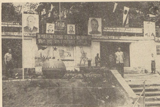
Trybuna stadionu w Swinoujściu
