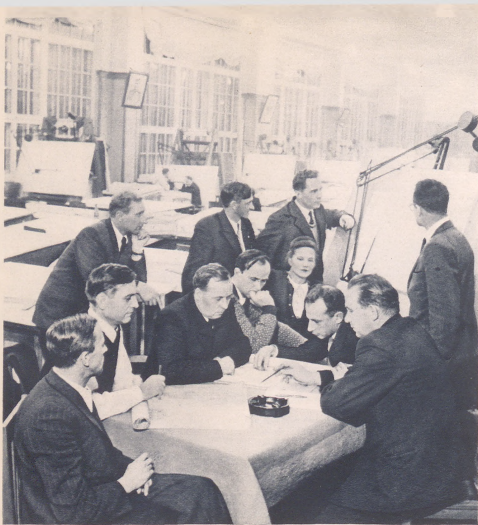
СТРАНА — СТРОЙКАМ КОММУНИЗМА. Разработка проектов сверхмощных турбин для волжских гидроэлектростанций в конструкторском бюро Ленинградского металлического завода имени Сталина. На втором снимке — зшелон леса, отправленный сверх плана лесорубами Бурят-Монголии на строительство гидроэлектростанций.
