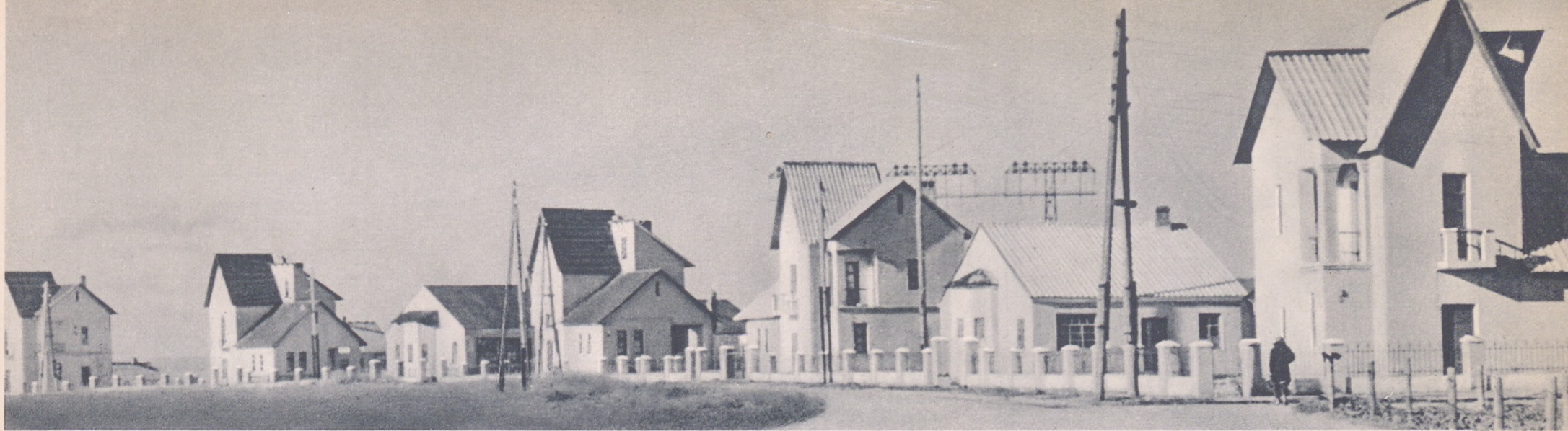
Для рабочих „Запорожстали“ возводятся многоэтажные жилые здания. Наряду с ними рабочие строят себе индивидуальные дома. Дирекция завода всячески помогает в этом застройщикам.
