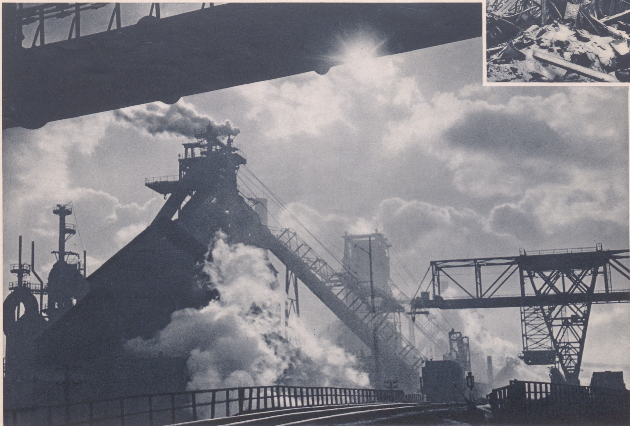
На руинах, оставленных гитлеровцами, вырос еще более мощный, чем прежде, красавец-завод, жемчужина черной металлургии Юга. На снимке — завод „Запорожсталь” сегодня; вверху справа — руины, оставленные фашистскими захватчиками на месте этого завода в дни второй мировой войны.
