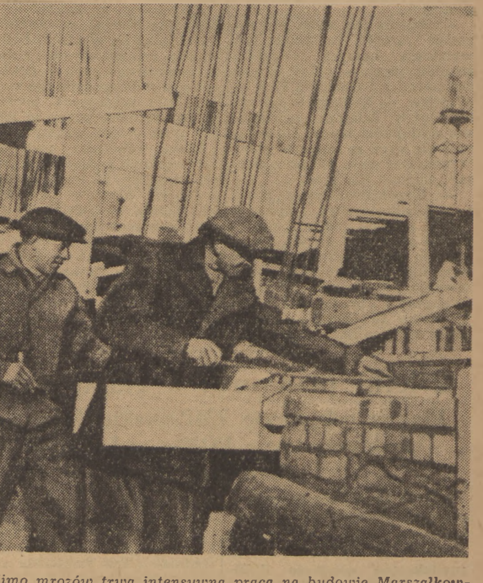
Mimo mrozów trwa intensywna praca na budowie Marszałkowskiej Dzielnicy Mieszkaniowej. Na zdjęciu: cieśla Lesiewicz deskuje słup pierwszego pietra bloku 7c. Lesiewicz z pomocnikiem Borowym i Cyruchem wyrabia precyzyjnie ponad 180 proc. normy.
