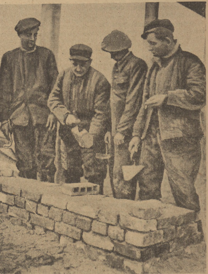
Wykwalifikowani murarze, zatrudnieni na budowie Fabryki Samochodów Osobowych na Żeraniu, uczą młodych robotników nowego zawodu...
