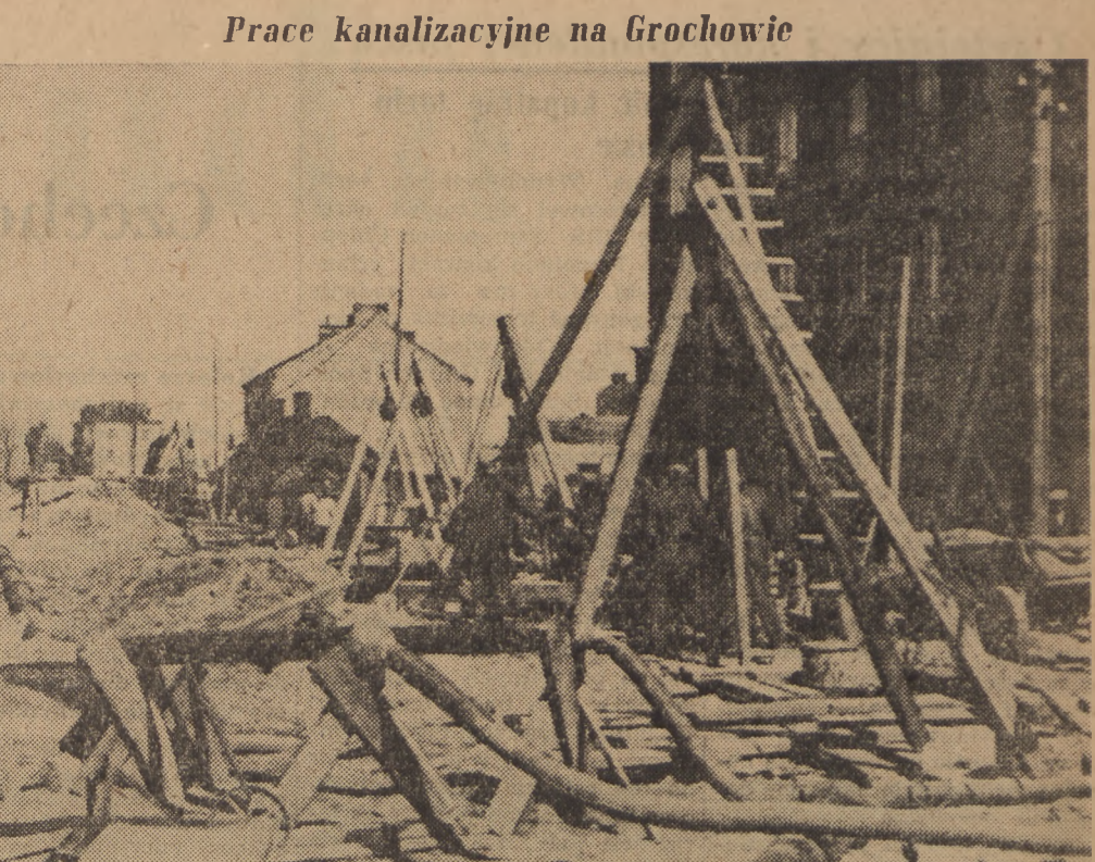
W bieżącym roku zostaną skanalizowane ulice w rejonie placu Szembeka. Roboty przeprowadza Miejskie Przedsiębiorstwo Robót Wodociągowych i Kanalizacyjnych. Na zdjęciu roboty kanalizacyjne na ul. Chłopińskiego.
