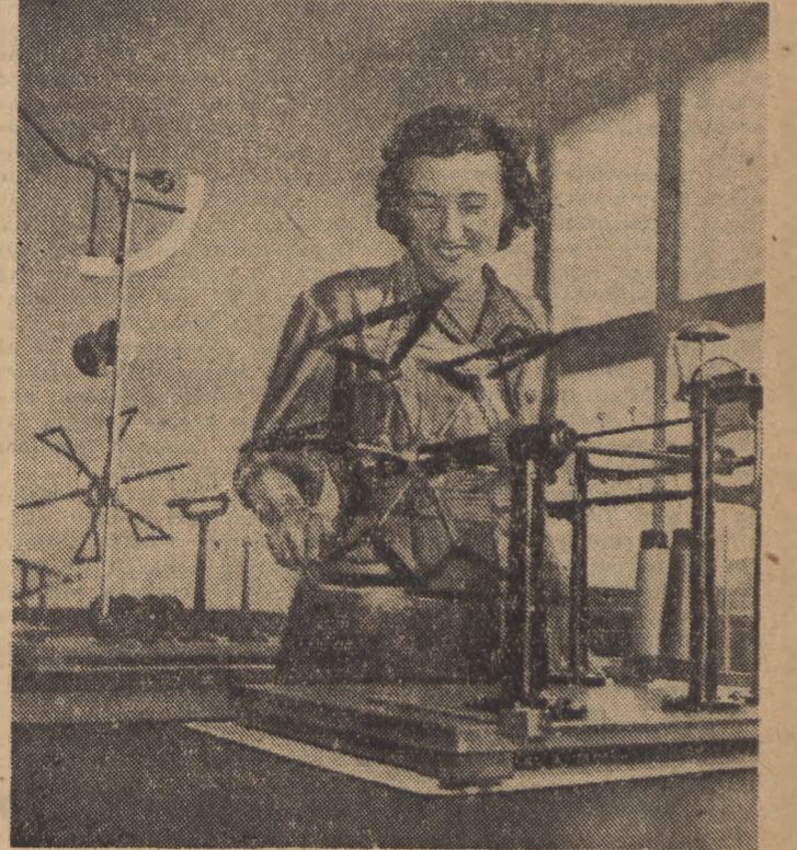
Gorzowska Fabryka Włókien Sztucznych posiada własne laboratorium. Na zdjęciu jedna z jego pracowniczek Regina Kasprzak, w czasie oznaczania grubości wyprodukowanego włókna sztucznego.
