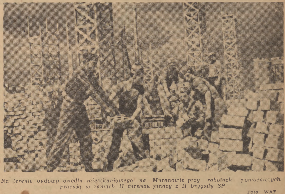
Na terenie budowy osiedla mieszkaniowego na Muranowie przy robotach pomocniczych pracują w ramach II turnusu junacy z II brigady SP. Foto WAF
