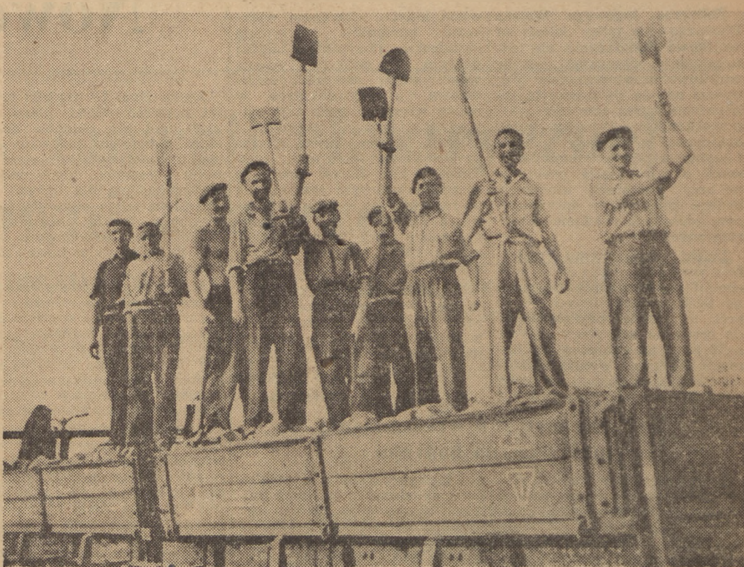
Przy odgruzowaniu terenów północnego Muranowa, na których staną nowe bloki mieszkalne, pracują mieszkańcy stolicy oraz pracownicy liczących zakładów pracy. Na zdjęciu grupa robotników zjednoczenia BW-3 (KAM), po załadowaniu wagonu gruzem.
