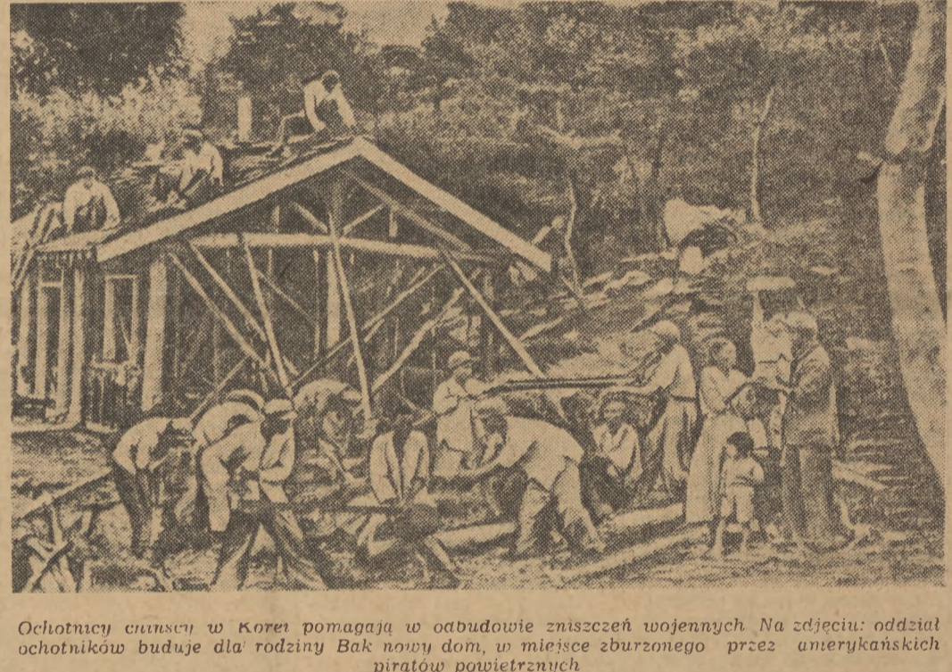
Chętnicy z pomocą w Korei pomagają w odbudowie zniszczonej wojennymi. Na zdjęciu: oddział ochotników buduje dla rodziny Bak nowy dom...
