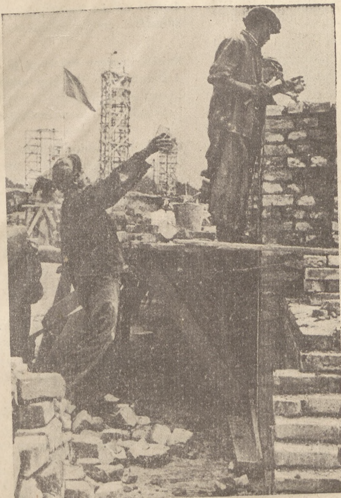
Budownictwo polskie ma za sobą wiele wspaniałych osiągnięć. W chwili obecnej w osiedlu Nowa Huta pod Krakowem powstaje największa w Europie — poza Związkiem Radzieckim — huta stalowa. Na zdjęciu brygada ZMP przy pracy w Nowej Hucie.
