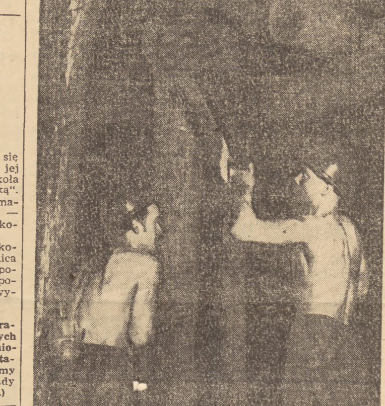
Na zdjęciu — Herter i Zawila przy budowie (foto — Czesław Datka)
