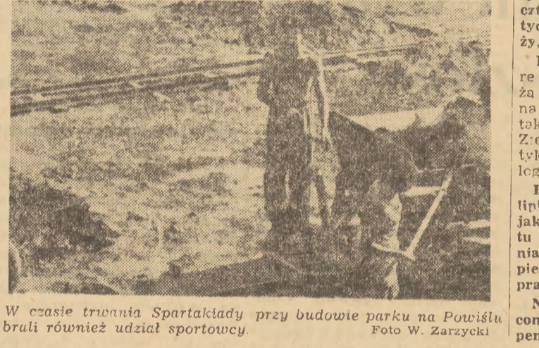
W czasie trwania Spartakiady przy budowie parku na Powiślu brali również udział sportowcy
