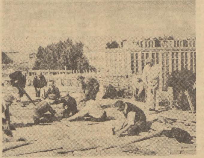
Jedną z najpiękniejszych uczelni Warszawy jest Szkoła Główna Planowania i Statystyki. Obok starego budynku, w którym mieści się biblioteka i sala wykładowa, buduje się nowy, piękny gmach o kubaturze 130 tys. m. sześciu. Na zdjęciu: fragment budowy nowego gmachu — w głębi SGP i S.
